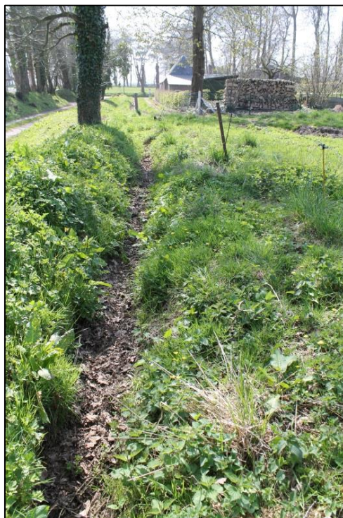
Photo n°1 Redimensionnement et prolongement du fossé existant
